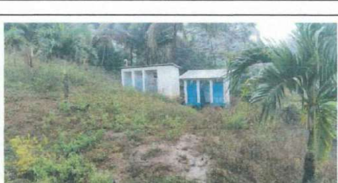
Foto 6: Se observa en la fotografía el riesgo de accidente involuntario de los niños en el camino al baño.
